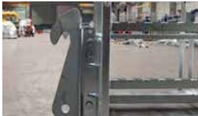
Illustration avec système de fixation vissé
